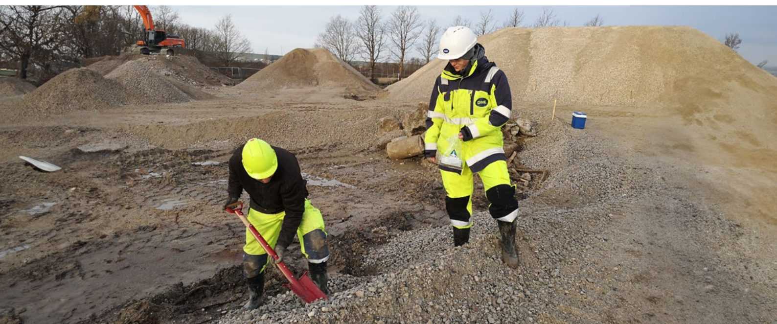
➤ Prøvetagning af nedknust beton.
