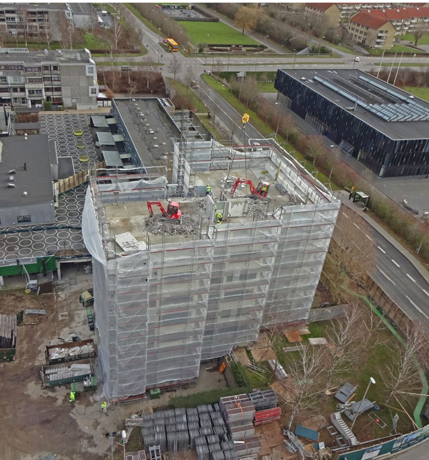
› Nedrivning af højhuse i Brøndby Strand
