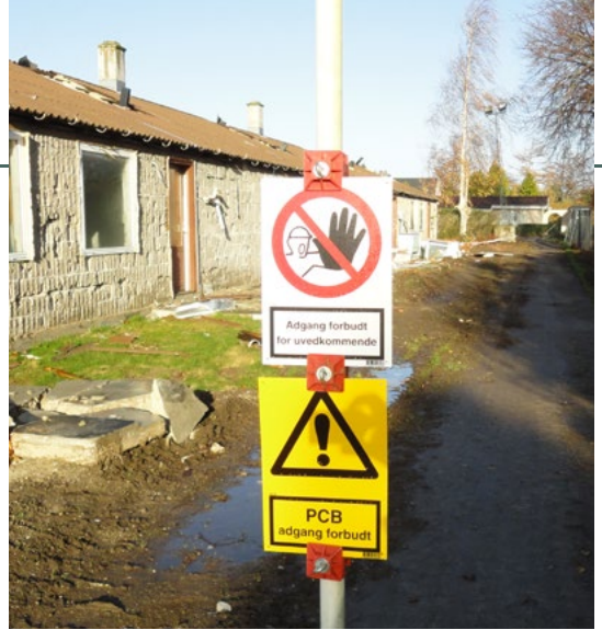
➤ "Adgang forbudt" skilt på byggeplads med PCB-forurening.
