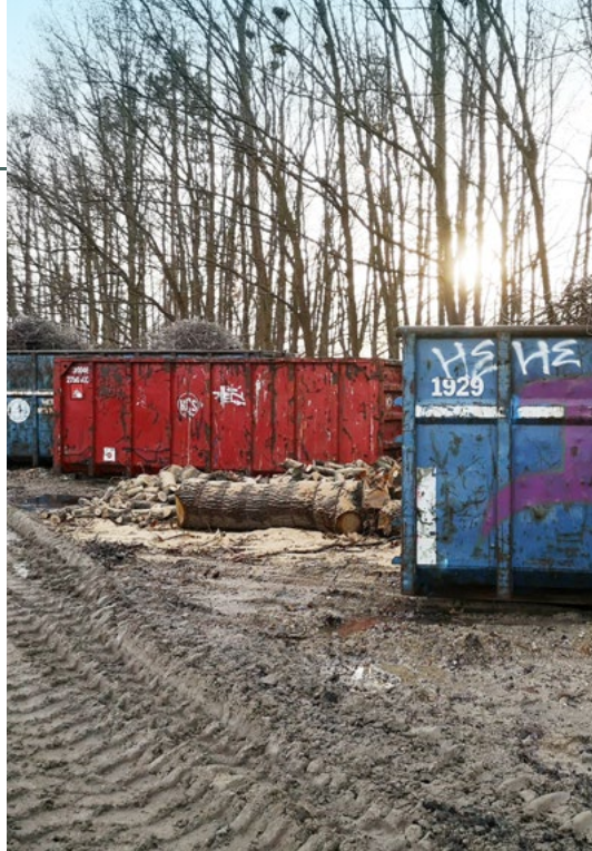
➤ Containere på byggepladsen til sortering af affald fra nedrivning
